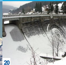
20 Elbe Dam (Labská přehrada)
